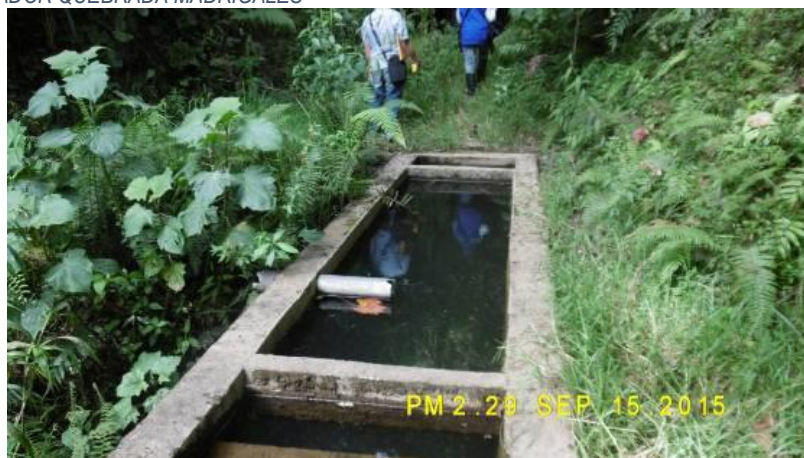
FIGURA 132. DESARENADOR QUEBRADA MADRIGALES
