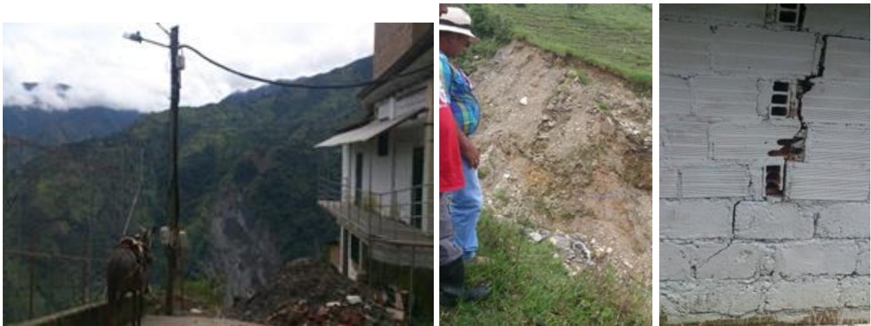
FIGURA 46 EL LLANO: GRIETA REMONTANTE COLINDANTE CON EL CPR, VISTA DESDE EL CPR DE OCHALI Y DESDE SU BORDE; AGRIETAMIENTO DE VIVIENDAS COLINDANTES CON ESTA GRIETA.
