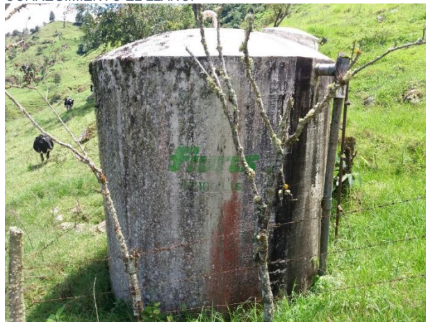
FIGURA 89. TANQUE DE ALMACENAMIENTO DE 15.000 L CORREGIMIENTO EL LLANO.
