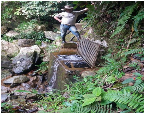
FIGURA 73. BOCATOMA SOBRE LA QUEBRADA MATAPOBRES, ABASTECE ACTUALMENTE AL CENTRO POBLADO EL CEDRO.
