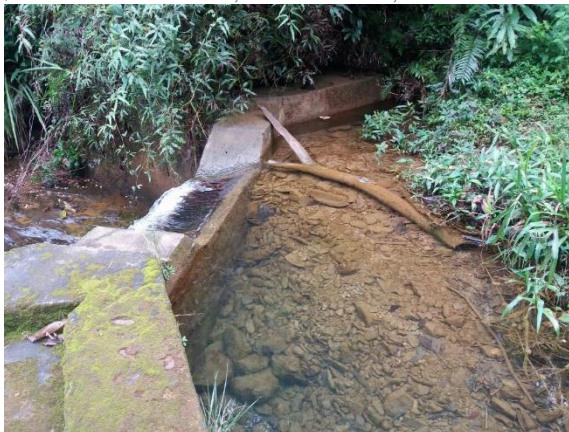
FIGURA 75. BOCATOMA SOBRE LA QUEBRADA LA TURBACO, FUERA DE USO, CENTRO POBLADO, EL CEDRO.
