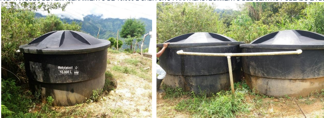
FIGURA 92. TANQUES DE ALMACENAMIENTO DE 10.000 L CADA UNO PARA ABASTECIMIENTO DEL CENTRO POBLADO LA LOMA
