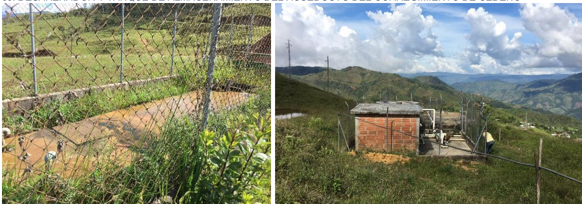
FIGURA 69. DESARENADOR Y TANQUE DE ALMACENAMIENTO DEL ACUEDUCTO DEL CORREGIMIENTO DE CEDEÑO
