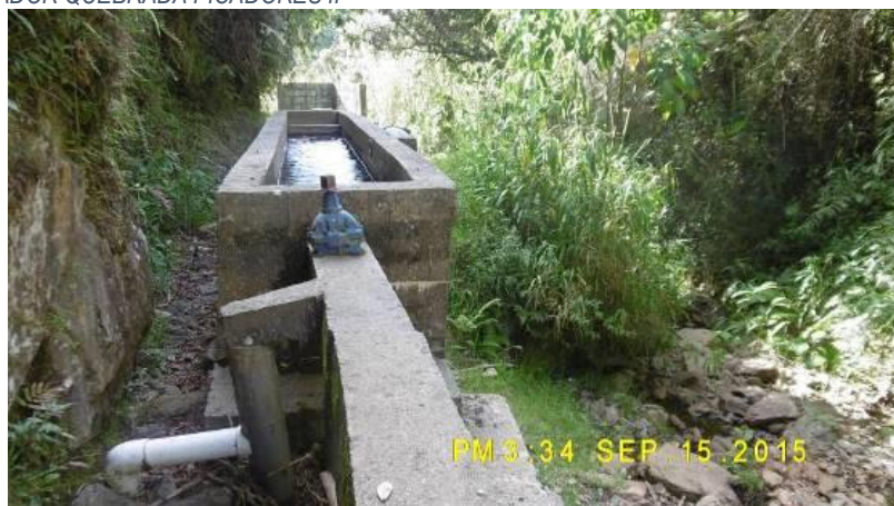
FIGURA 131. DESARENADOR QUEBRADA PICADORES II
