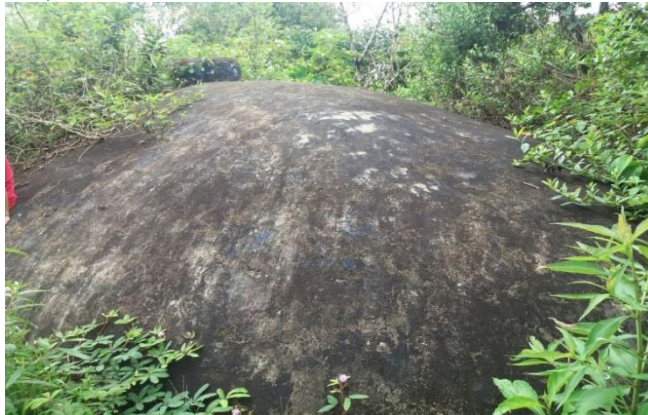
FIGURA 76. TANQUE DE ALMACENAMIENTO DE LA CAPTACIÓN DE LA QUEBRADA TURBACO, NUNCA SE PUSO EN FUNCIONAMIENTO POR PROBLEMAS ESTRUCTURALES, CENTRO POBLADO EL CEDRO.
