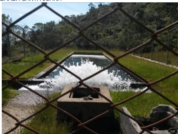
FIGURA 129. DESARENADOR QUEBRADA SANTA JUANA
