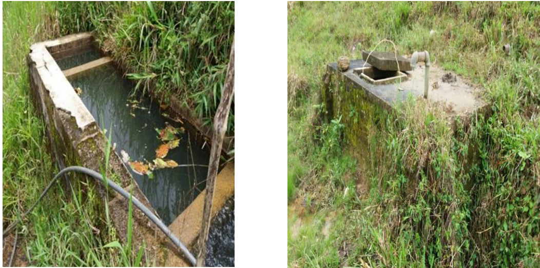
FIGURA 84. DESARENADOR Y TANQUE DE ALMACENAMIENTO DEL ACUEDUCTO DE LA VEREDA AGUACATALA
