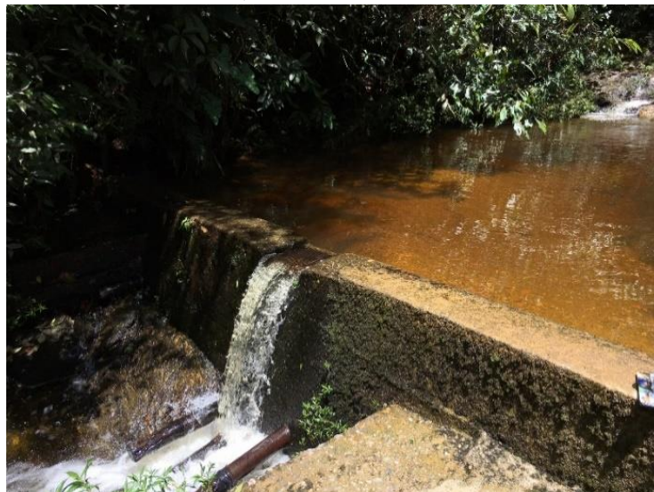
FIGURA 68. BOCATOMA SOBRE LA QUEBRADA EL PEÑOL, ACUEDUCTO DEL CENTRO POBLADO DE CEDEÑO
