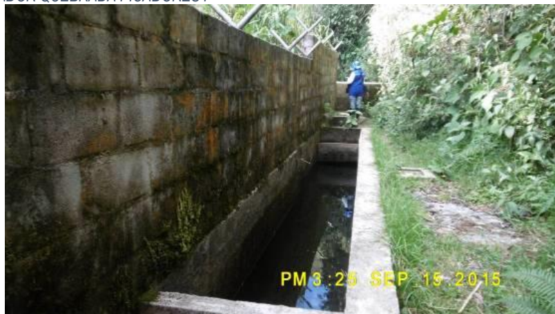
FIGURA 130. DESARENADOR QUEBRADA PICADORES I
